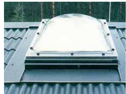
Mājas virsgaismas logs, uzstādīts uz rievota jumta seguma.
